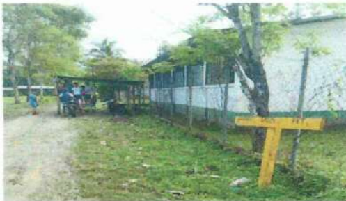
Foto 5: La foto evidencia la necesidad de levantar el muro perimetral.
