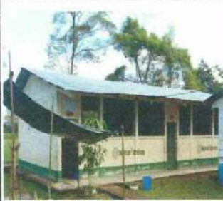
Foto1: Las fotos evidencian el cambio de lámina de las aulas y los servicios sanitarios.
